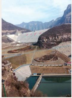
河口村水库是河南省重点建设项目,被国务院纳入172 项重大水利工程,农发行贷款296亿元支持该项目建 设。河口村水库总库容3.17亿立方米,装机容量11.6千 瓦,可在农业供水不减少的同时向城市生活和工业供 水12.828万立方米,年平均发电量约3.435万千瓦,有 利于提高黄河下游防洪控洪能力,解决沁南地区用水 问题,改善当地水利生态环境。•
